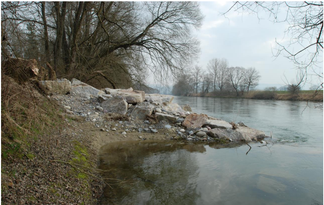
Neu erstellte Buhne am Reussufer
